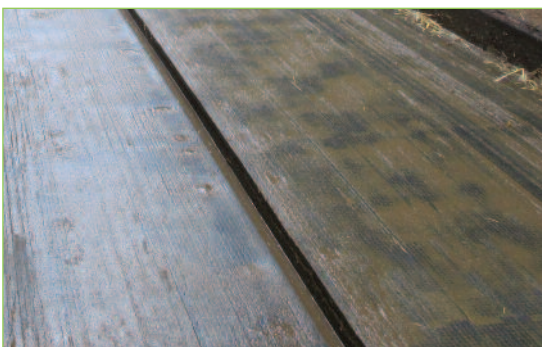
Photo 30 : Fixation des tapis correctement réalisée.
