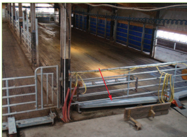
Photo 37 : Barrière poussante raclante.
