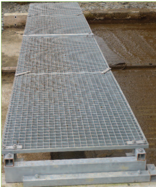
Photo 15 : Protection au-dessus d'un canal à lisier.
