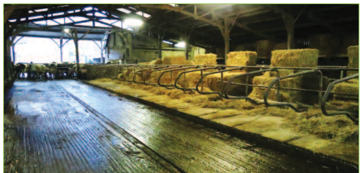
Photo 3 : La formation de flaques sur le couloir de circulation témoigne de la présence de contre-pentes.
