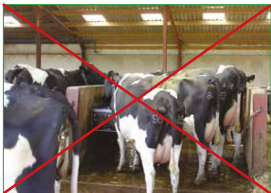
Photo 40 : Passage avec abreuvoir, à double sens et trop restreint : les vaches dominantes bloquent le passage en particulier en période de forte consommation (dans ce cas en été, à plus de 30°C)
