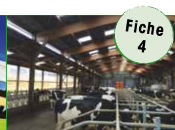
L'éclairage naturel et artificiel
