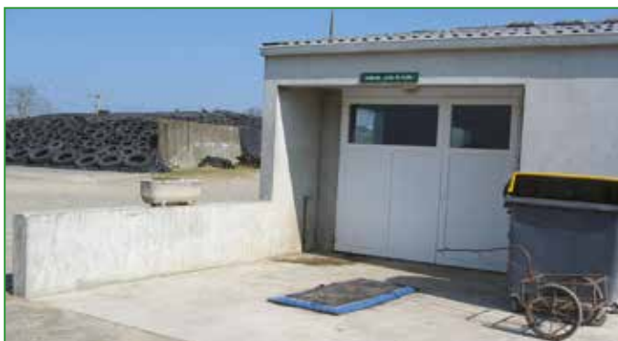
Photo 11 : Pédiluve à l'entrée d'un bâtiment.
