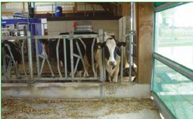
Photo 72 : Passage d'homme de 35 cm libre en bout de couloir, pouvant aussi être utilisé par les animaux...
