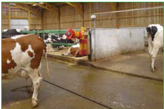
Photo 39 : Passage avec double pente vers les couloirs et marche réduite, en conduite lisier et raclage fréquent.
