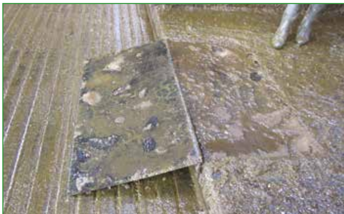
Photo 57 : Un pont amovible métallique autoconstruit par l'éleveur pour faire passer le matériel d'entretien d'un couloir à l'autre.
