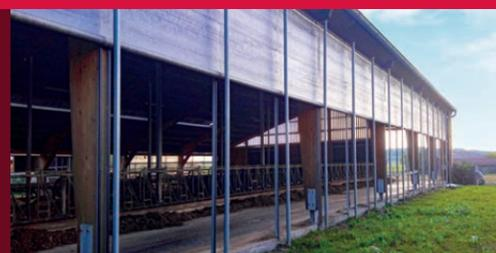
Pour assurer le confort des vaches, il est d'abord nécessaire de réduire le rayonnement solaire à l'intérieur des bâtiments. Les pistes d'amélioration portent d'abord sur la diminution voire la suppression totale des plaques translucides en toiture pour limiter l'effet de serre et ensuite sur la réduction drastique de la hauteur des maçonneries de sous-bassement des bâtiments. En effet, le béton absorbe la chaleur pendant la journée et la restitue en soirée.
